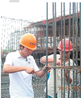
建筑工程学院学生在工地实践
